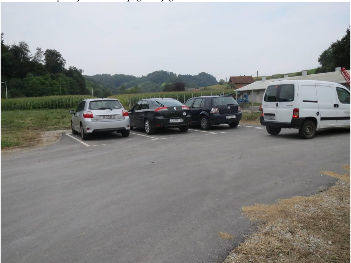
Slika 10. Parkiralište smješteno izvan ograde farme, ali unutar građevne čestice
