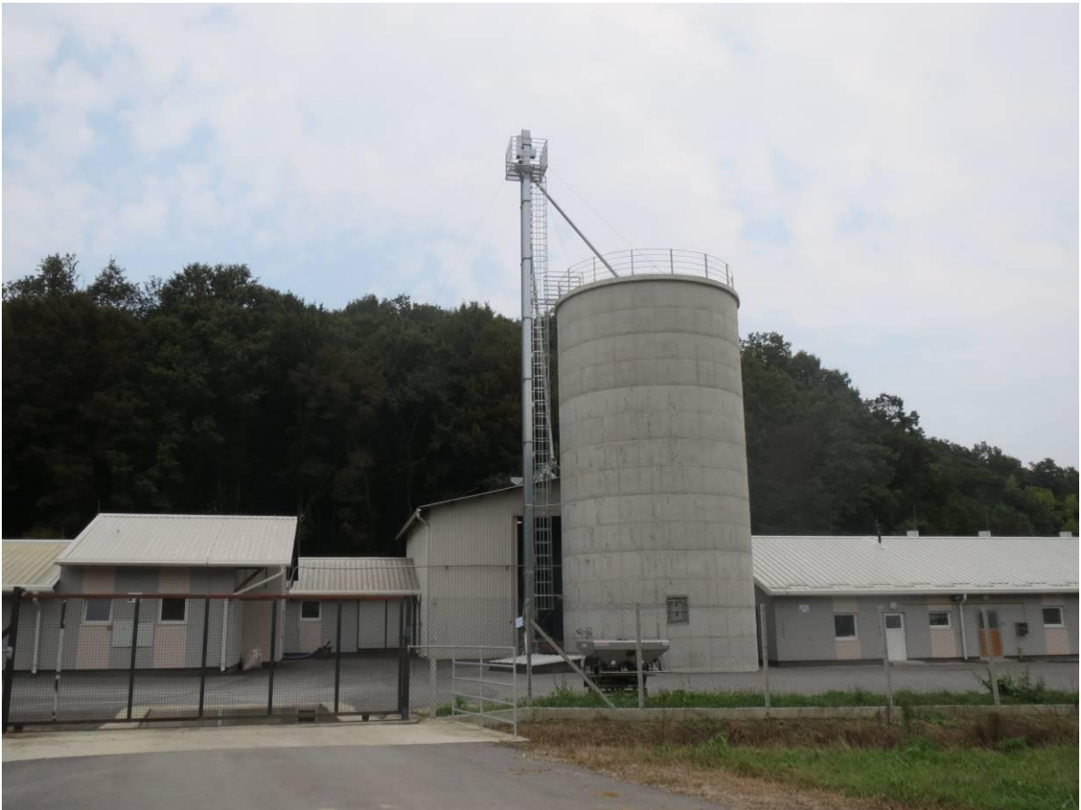
Slika 9. Ulaz u postojeću farmu – pogled s juga
